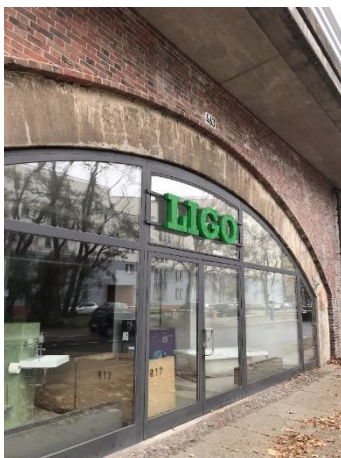
Abbildung 66: Sanitär-, Heizungs- und Klimatechnikunternehmen LIGO
