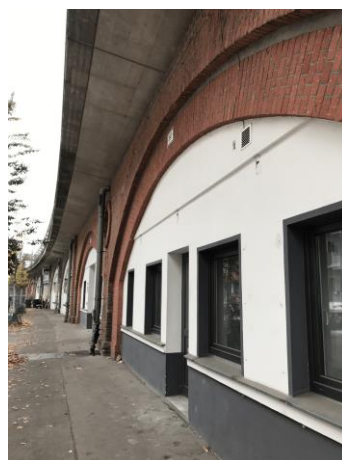
Abbildung 79: Renovierter Leerstand in den Stadtbahnbögen 396-397
