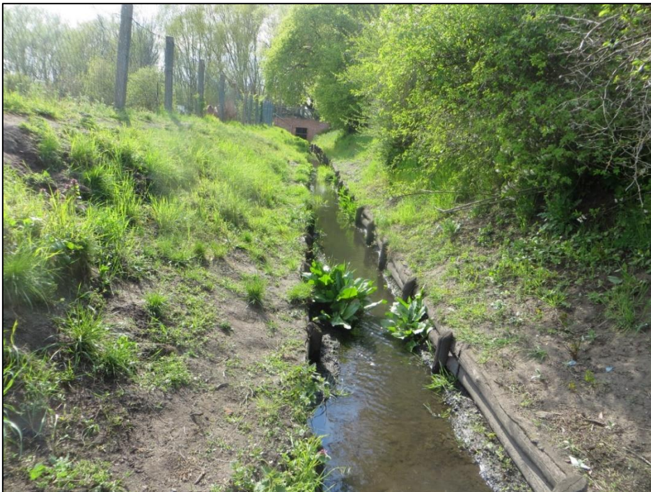
Graben– Blick nach Westen (M. Weber)
