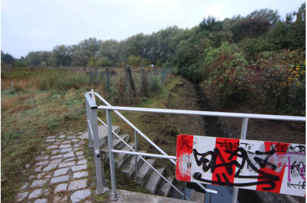
Abb. 8: Rohrpfehlgraben im Nordwesten des B-Plangebietes
