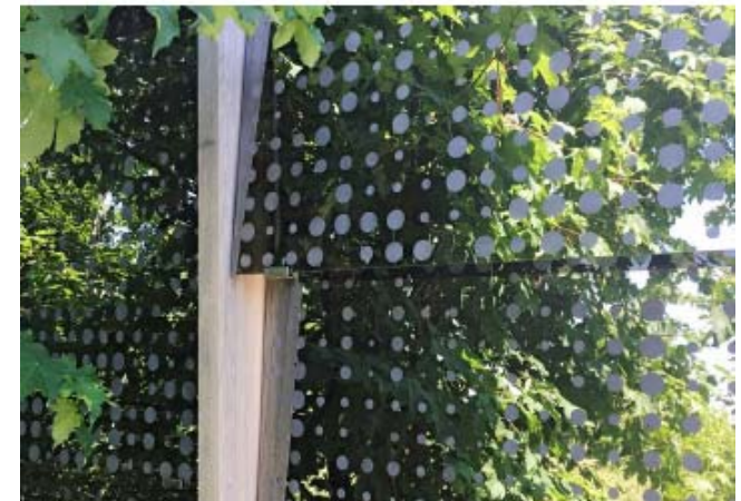
Vogelfreundliche sandgestrahlte Glasfassade (Glasbroschüre 2022, S.44)
