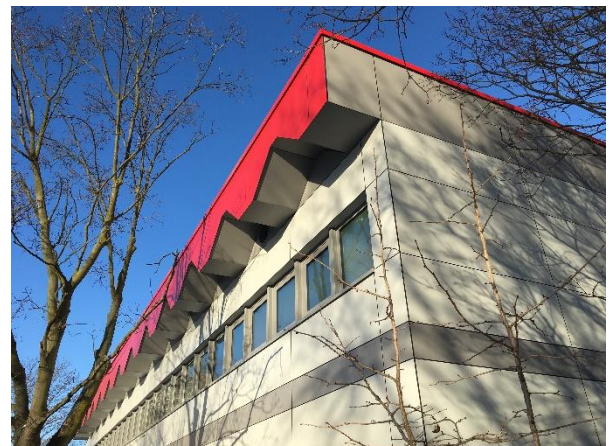
Foto 6: Hagenstr. 26 nach der Sanierung
