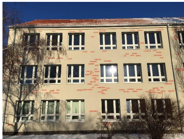
Foto 4: Lisztstr. 6 nach der Sanierung
