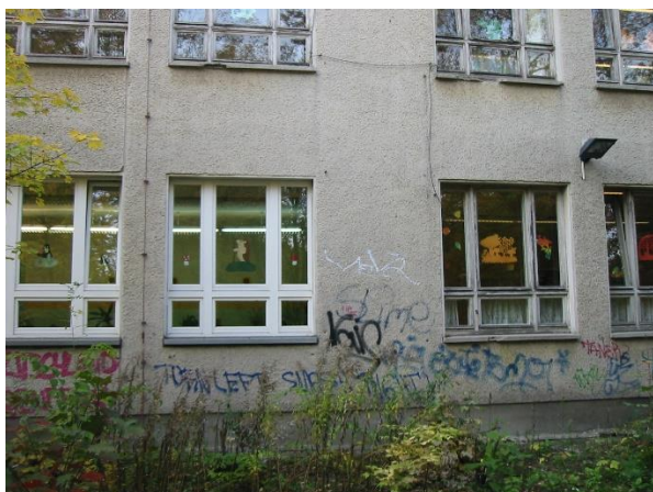
Foto 3: Lisztstr. 6 vor der Sanierung
