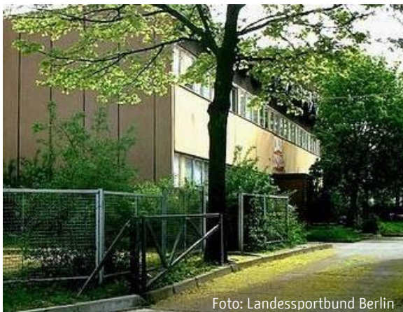
Foto 5: Hagenstr. 26 vor der Sanierung
