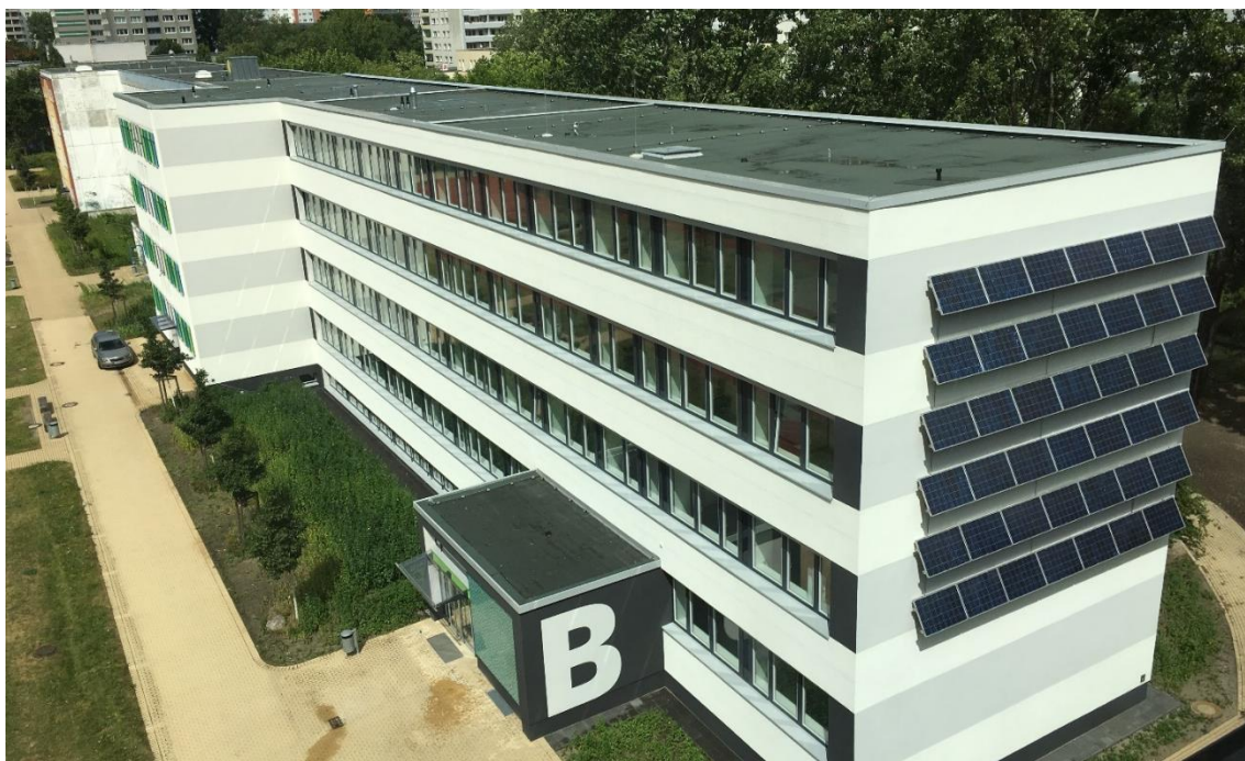
Foto 1: Photovoltaikanlage an der Fassade des J.-G.-Herder-Gymnasiums, Franz-Jacob-Str. 8
