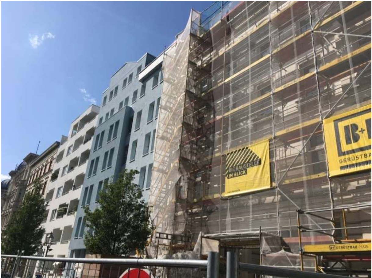
Abbildung 6: Laufende Modernisierungsmaßnahme in der Hagelberger Straße
