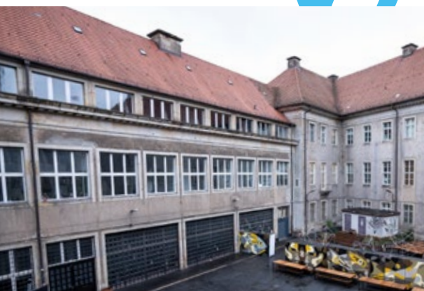
Bauteil V: Lager, Werkstatt und Wohngebäude Bauteil Bauteil VII: Hof, Sockelgeschoss, Lager, Heiz- und Kesselraum, Transformatorstation
