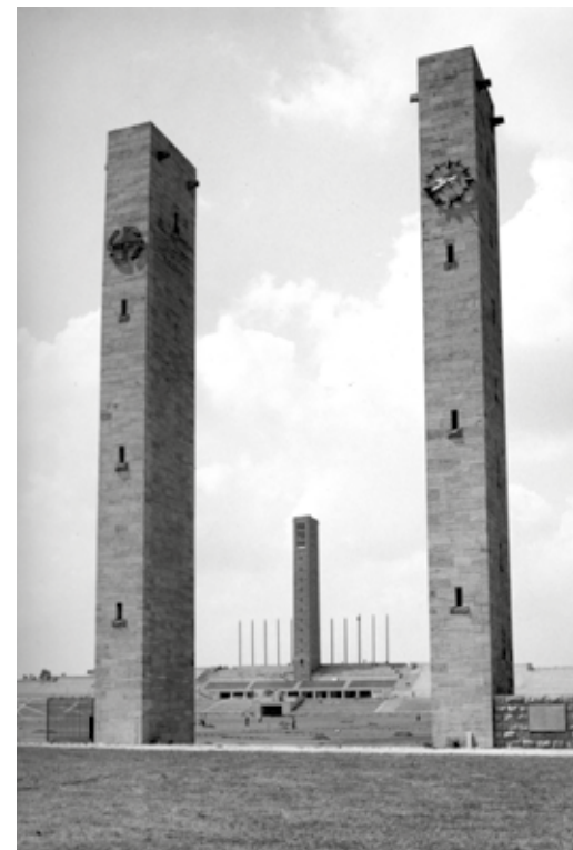
Friesen- und Sachsenturm am Olympiastadion, im Hintergrund der Glockenturm
