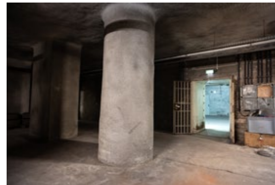
Tresor im 2. Untergeschoss
