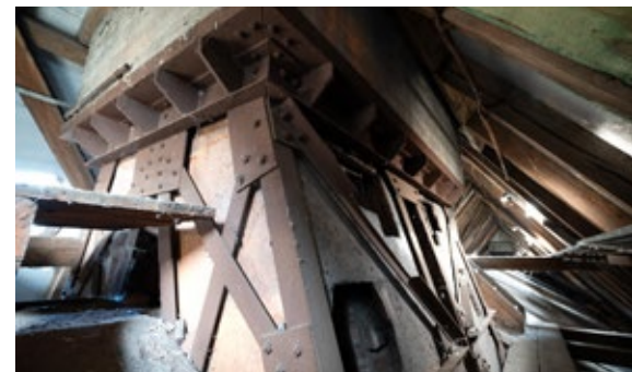
Unterkonstruktion der Schornsteine
