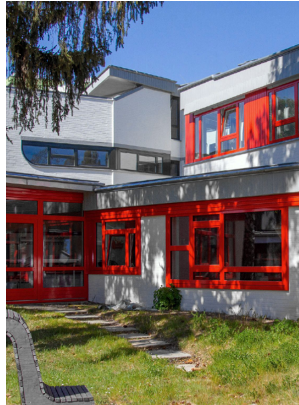
Atrium nach der energetischen Sanierung © Bianka Gericke
