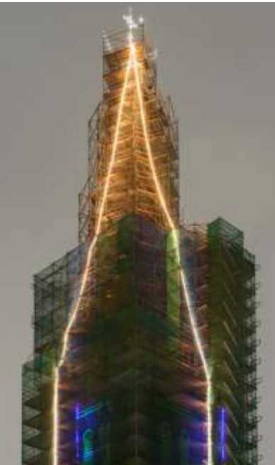
Abbildung links // Nächtliche Beleuchtung in der Bauphase
