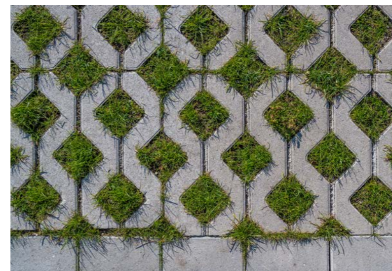
Beispiel Entsiegelung: Rasengittersteine, Foto: Berliner Regenwasseragentur, Andreas (Franz Xaver) Süß
