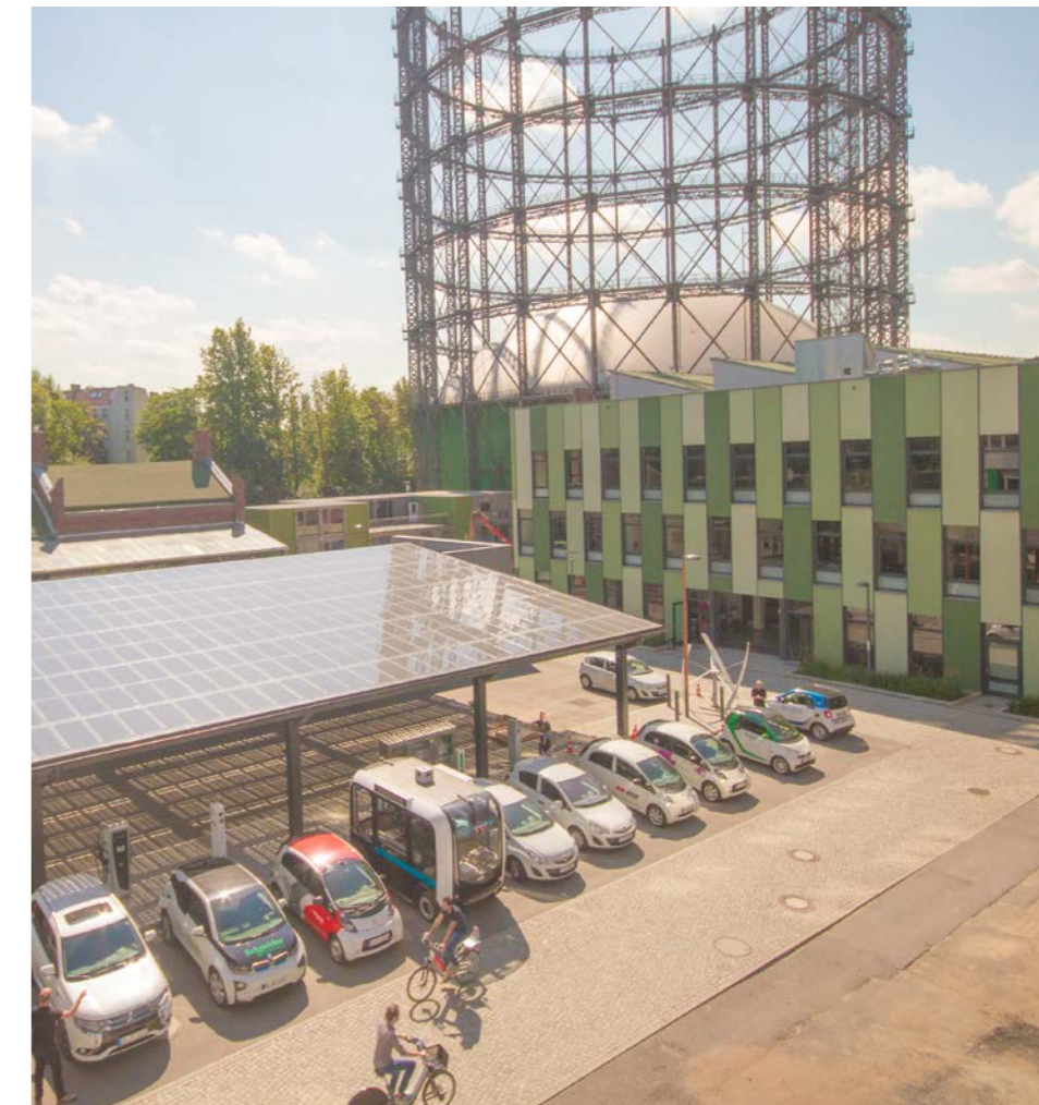
Eigenstromerzeugung durch PV-Anlagen am Schöneberger EUREF-Campus, Quelle: Vipul Toprani, Inno2grid GmbH
