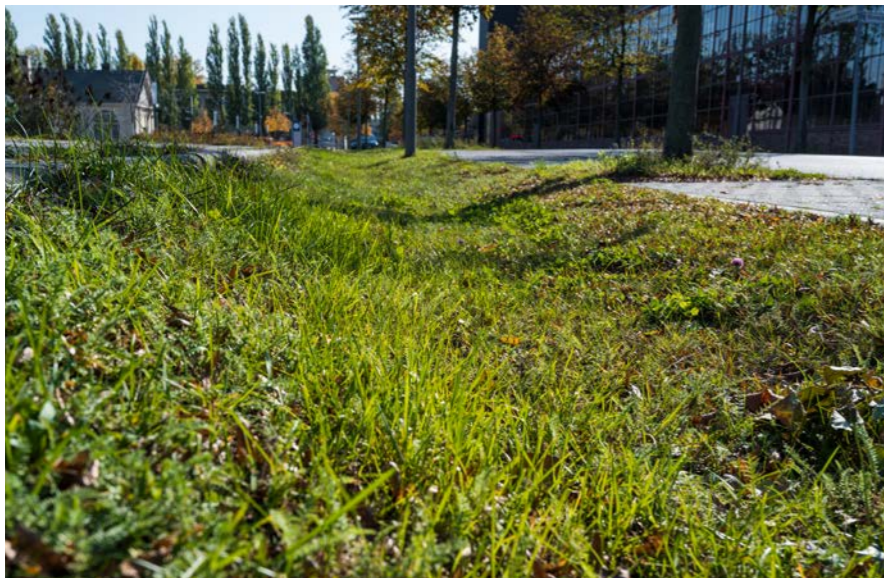
Beispiel Mulden-Rigolen-System in Adlershof, Foto: Berliner Regenwasseragentur, Andreas (Franz Xaver) Süß
