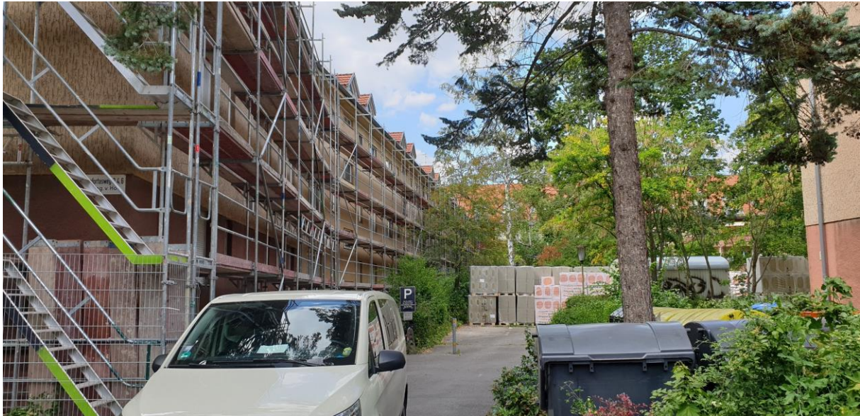
Abbildung 29: Energetische Fassadensanierung im Amfortasweg
