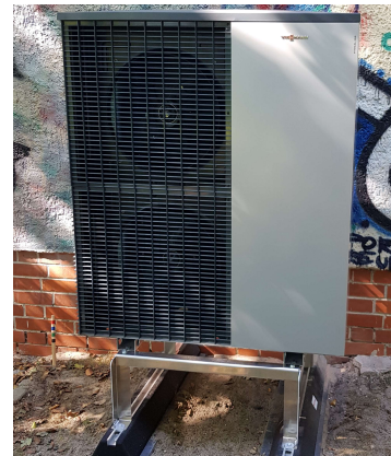
Abb. 3. Wärmepumpe Außeneinheit
