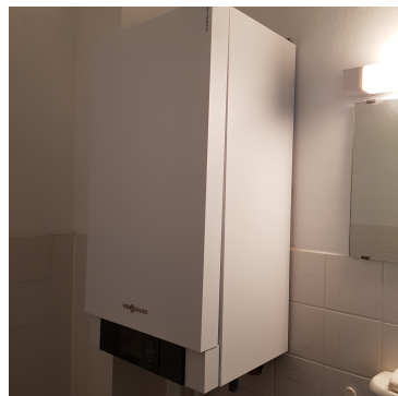
Abb. 2. Wärmepumpe Inneneinheit
