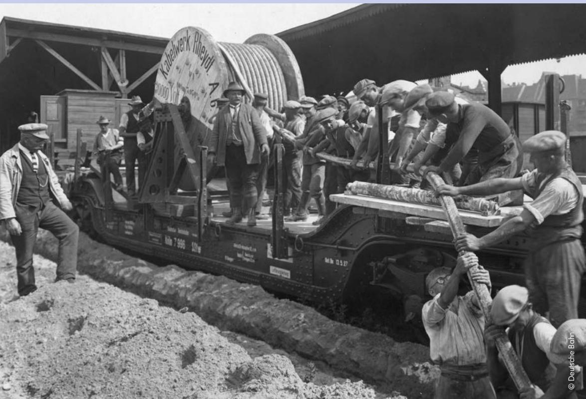
S-Bahn-Elektrifizierung in Berlin: Kabellegung in Spandau West; o. J./ um 1927.
