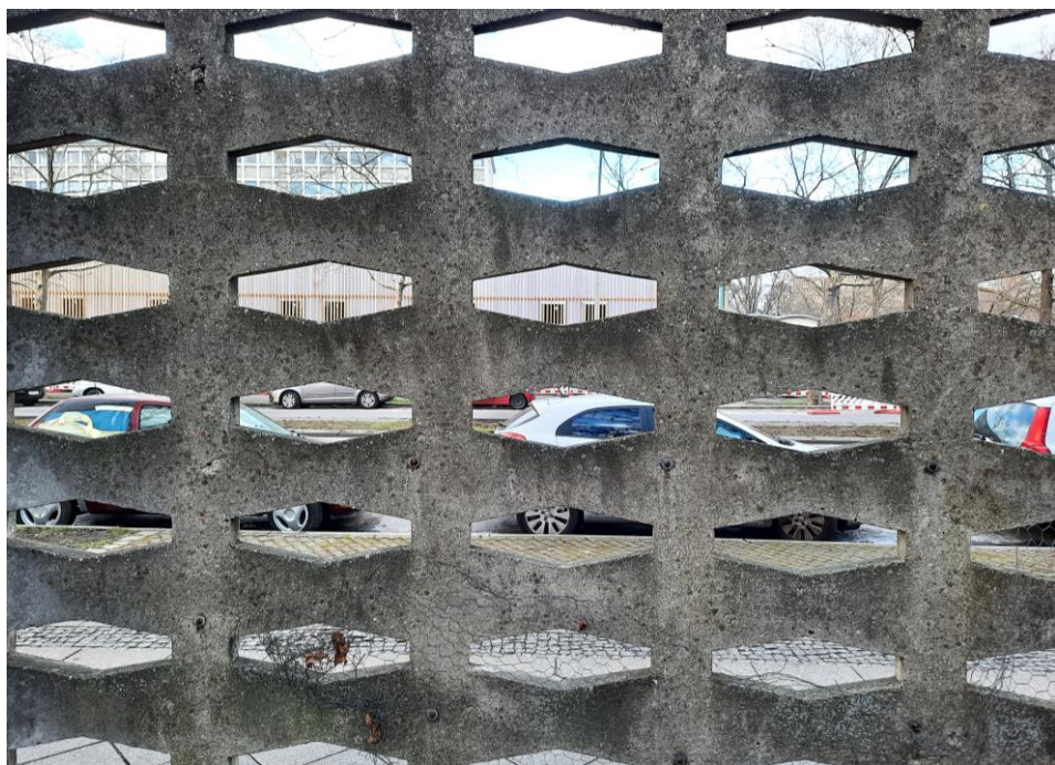
Nordseite: Perforierte Betonsteinmauer (1971) Richtung Blücherstraße und AGB Bildnachweis: Grün Berlin
