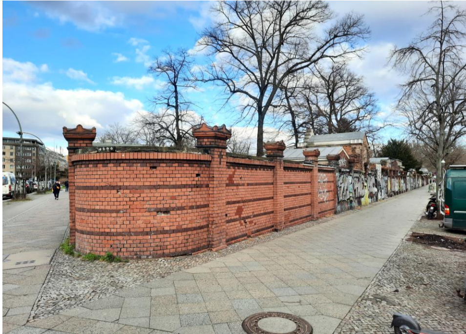
Äußere Friedhofsmauer Mehringdamm Ecke Baruther Straße Bildnachweis: Grün Berlin
