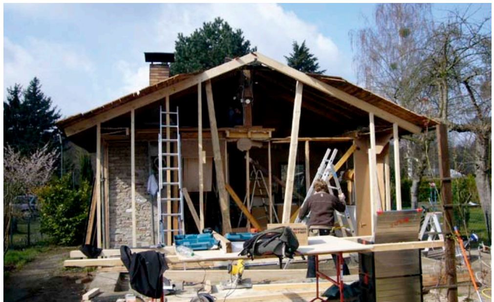
© Hütten & Paläste Architekten/Jan Stauf
